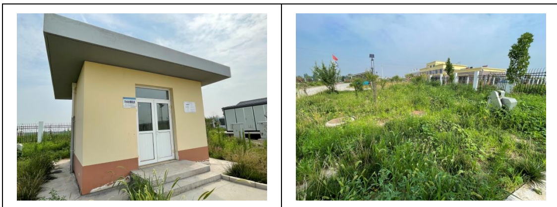
高阳西收费站（高阳养护工区）污水处理设施
