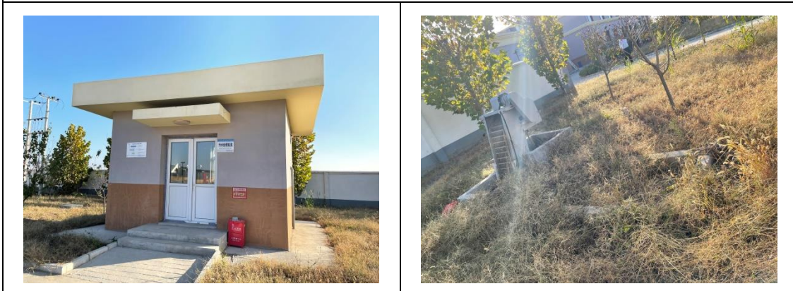
博野东收费站（博野养护工区）污水处理设施
