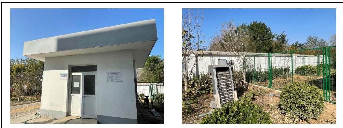
安国南收费站（监控中心）污水处理设施
