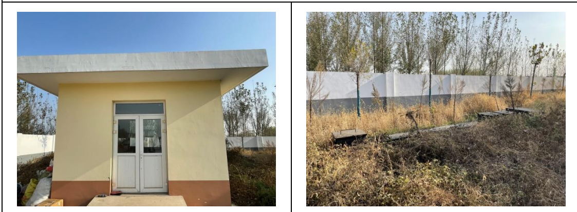
蠡县服务区污水处理设施
