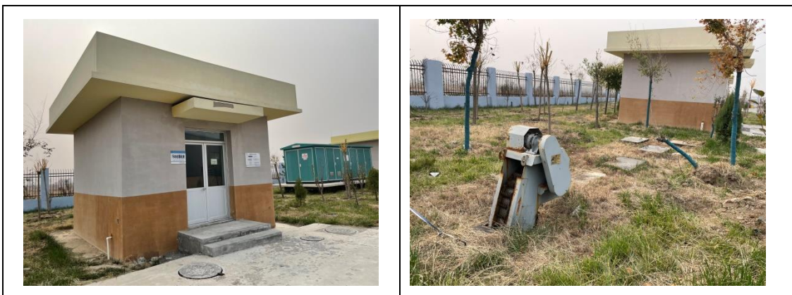
大城西收费站（大城养护工区）污水处理设施
