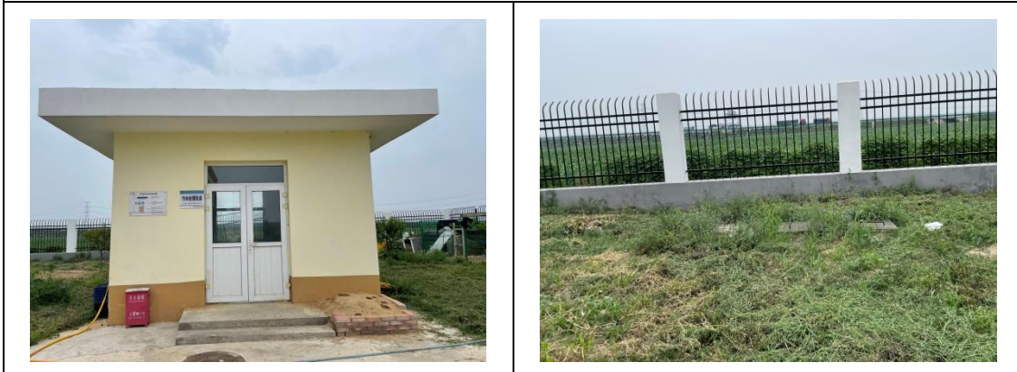
蠡县北收费站污水处理设施
