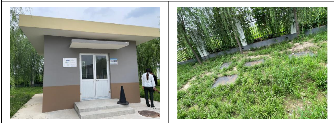
任丘开发区收费站（任丘养护工区）污水处理设施
