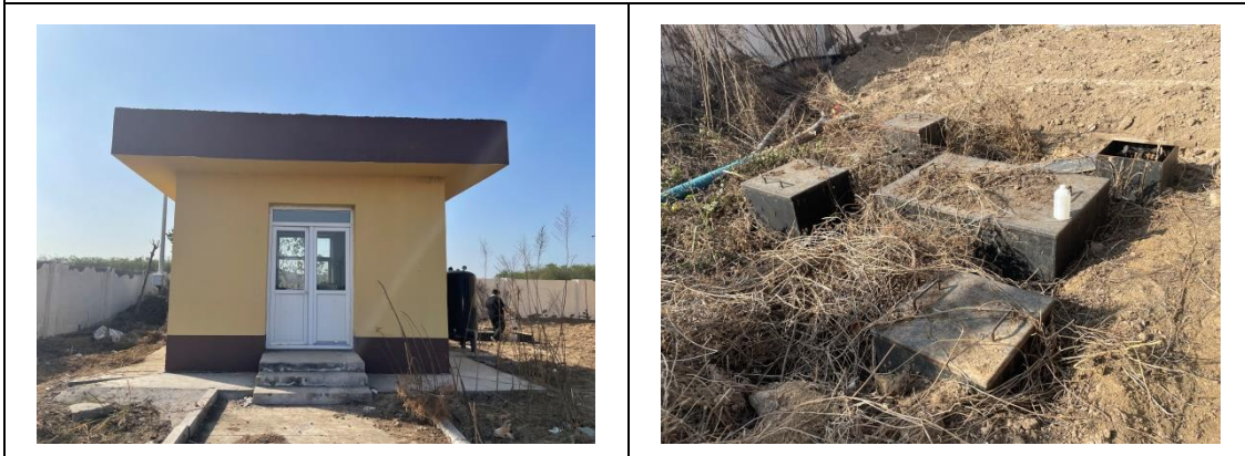
安国服务区污水处理设施
