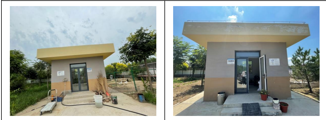
梁召收费站污水处理设施
